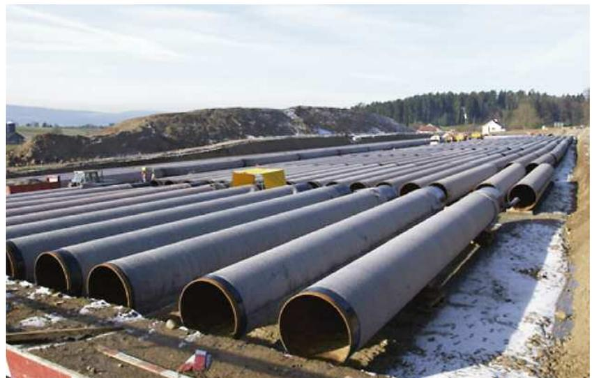
Abbildung 7: Röhrenspeicher in Gutenswil in der Schweiz während der Bauphase (Quelle: Erdgas Zürich AG)
