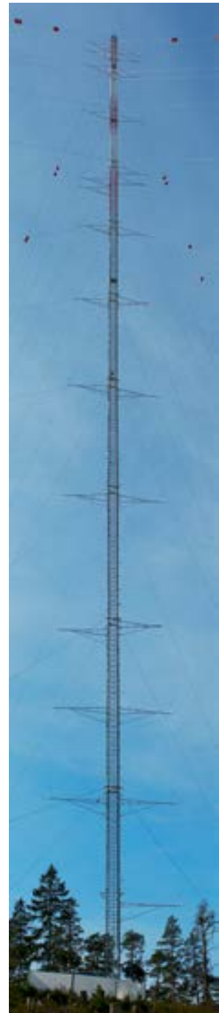
200-Meter-Messmast bei Wolfhagen / Kassel, © Fraunhofer IWES
